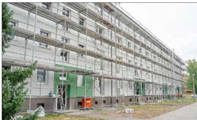
WIS-Bauprojekte Heinrich-Heine-Straße 22-25 und Juri-Gagarin-Straße 36-39 Foto: R. Meier zu Ummeln
