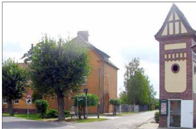
Häuschen untergebracht ist. Die Bauweise als Turm hatte den Vorteil, dass Freileitungen direkt am oberen Teil des Turmes abgespannt und ins Innere geführt werden konnten, ohne dass es eigens dafür einen Abspannmast benötigte. In einer solchen Transformationssta-
