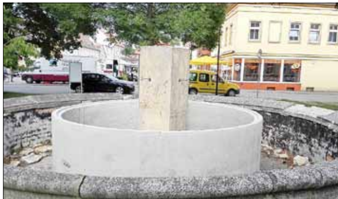
Der äußere Brunnenring steht und die Wasserhähne sind montiert.
