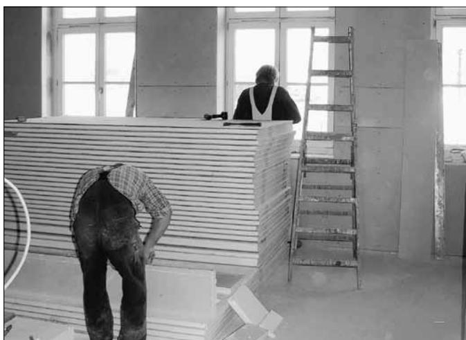
Arbeiter schneiden Styroporplatten zur Wärmedämmung zurecht.
