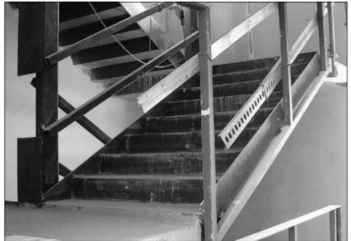
Das Stahlgerüst des neuen Treppenhauses ist bereits eingebaut.
